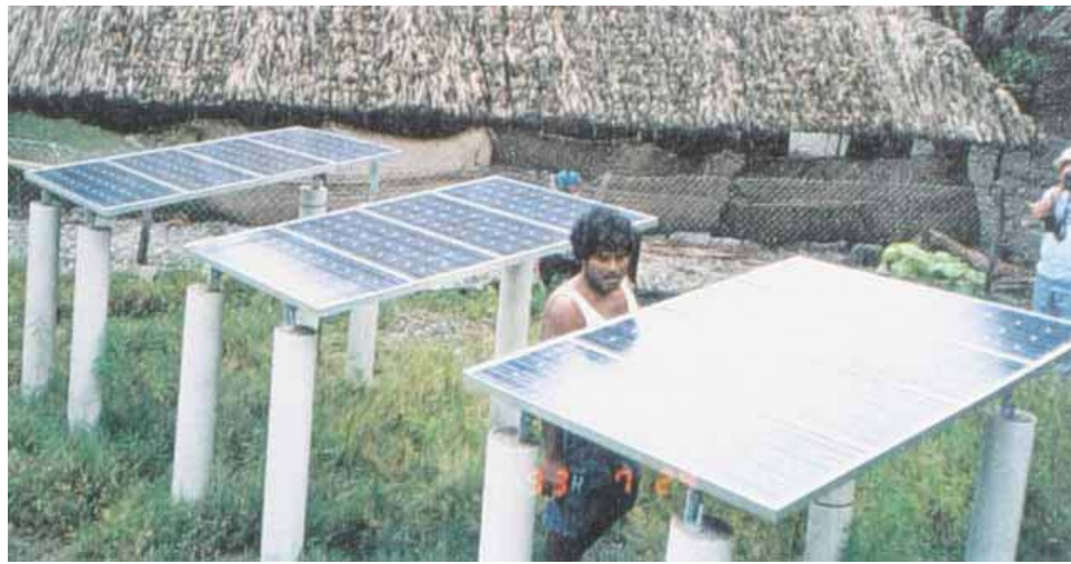
Figure 4-3 - Maneapa panel installation (Kainaba)
